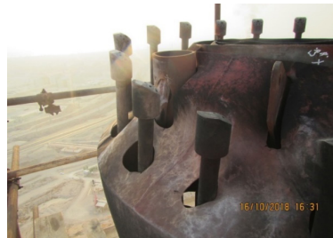
شکل ۱: تصویر واقعی، نمای از راست و ایزومتریک تیپ فلر LPG
