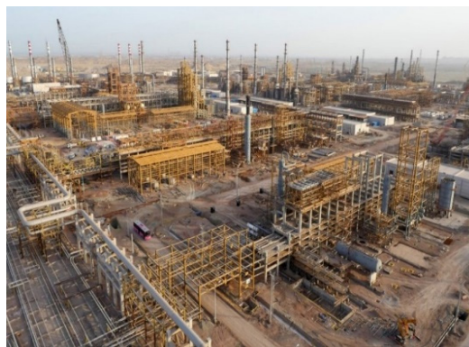
شکل ۱: پایپرک‌های مورد استفاده در پالایشگاه نفت ستاره خلیج فارس
