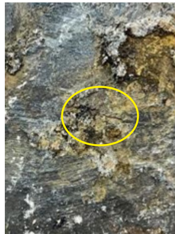
شکل ۷: ترک های مشاهده شده روی سطح لوله
