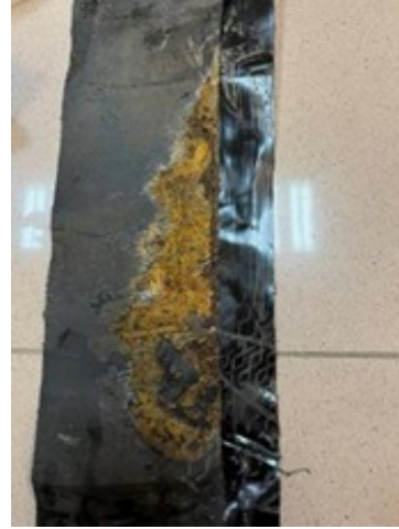
شکل ۶: هم پوشانی نوار پوشش اجرا شده
